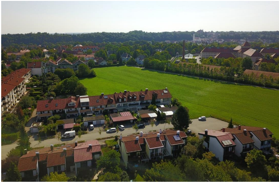
Abbildung 20 Blick nach Osten über das Gesamtgelände
