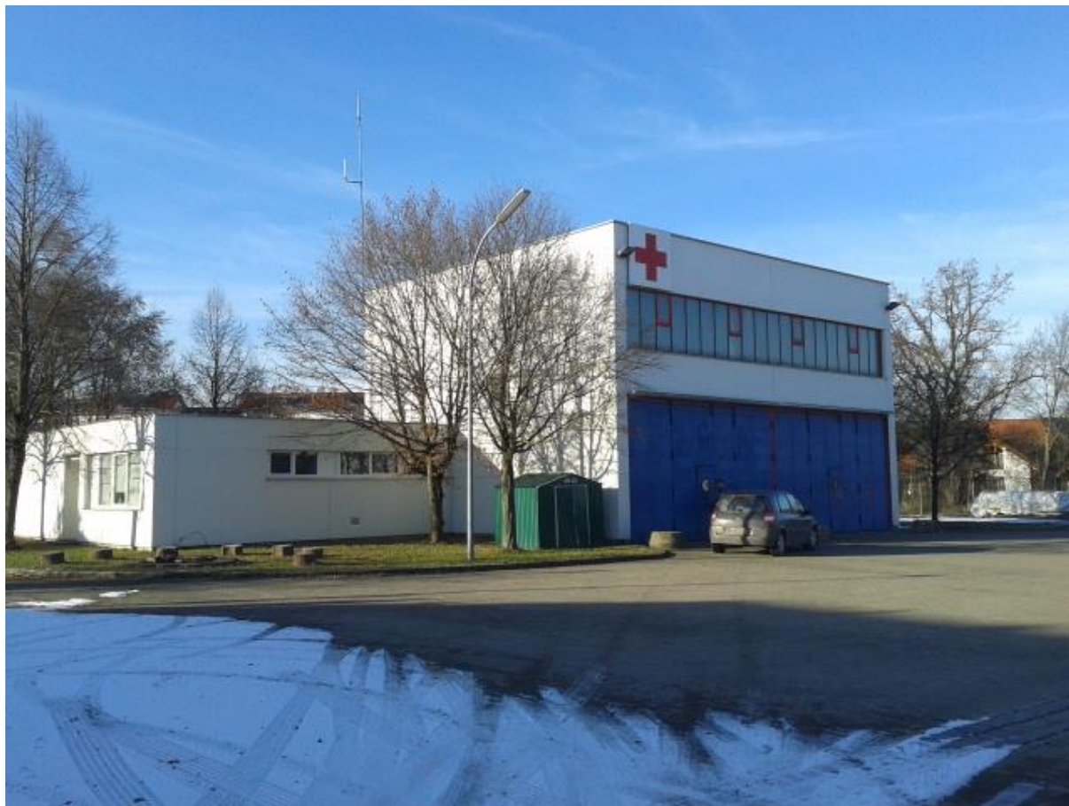
Abbildung 7: Bestandsgebäude BRK; eigene Aufnahme 03.12.2013
